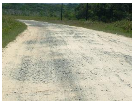
Foto 38: Estrada com solo bastante arenoso e pouco revestimento de brita (Av. da Praia - B. Pedrinhas - Ilha Comprida)
