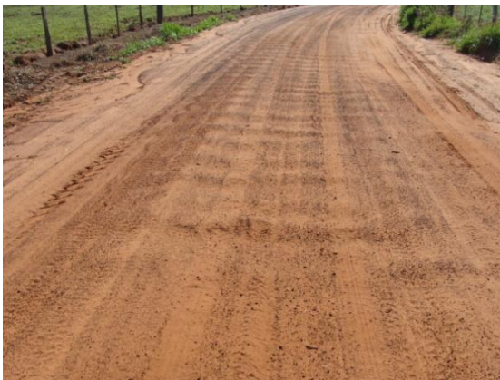
Foto 19: Ondulações na pista (FND-451 - Fernandópolis)
