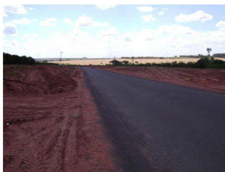
Foto 36: Estrada pavimentada logo após realização das obras do Melhor Caminho (ITP-156 - Itápolis)
