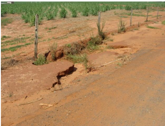
Foto 1: Formação de erosão na lateral da estrada (VTG-287 - Votuporanga)
