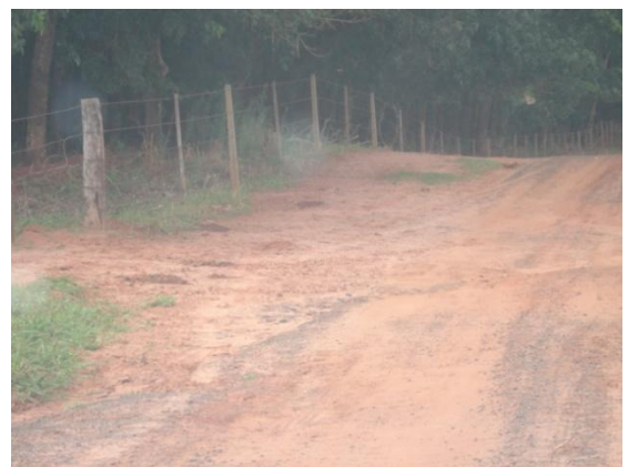
Foto 34: Pista de rolamento bastante irregular, com muitos buracos (MGD-441 - Magda)
