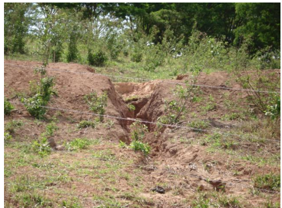
Foto 22: Caixa de contenção rompida (BGI-060 - Birigui)
