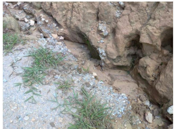
Foto 2: Formação de erosão na lateral da estrada (CBP-195 - Capão Bonito)
