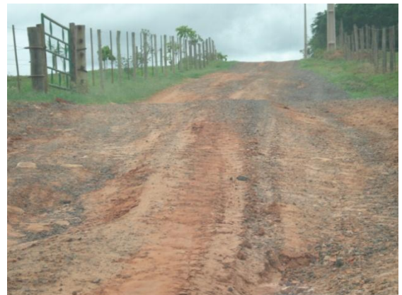
Foto 30: Pista de rolamento bastante irregular, com muitos buracos e atoleiros (LIN-448 - Lins)
